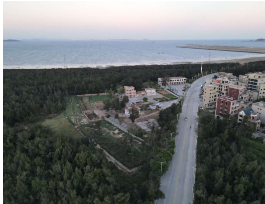
拟建小岞 110kV 变电站站址东北侧
