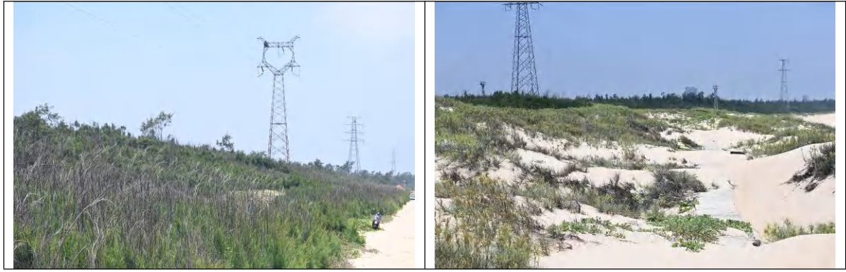
图 B-12 惠化~惠东 \pi 入小岞变 110kV 线路工程现状照片
