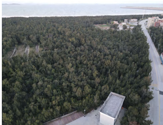
拟建小岞 110kV 变电站站址西北侧
