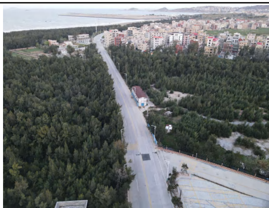
拟建小岞 110kV 变电站站址东南侧
