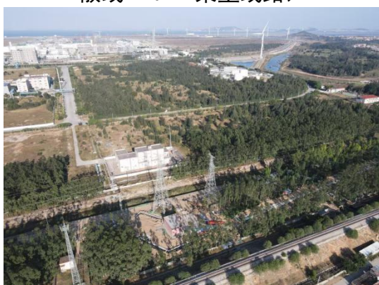
已建散湖变周边现状（凤散线#1、南散线#61、涂散板线#4）
