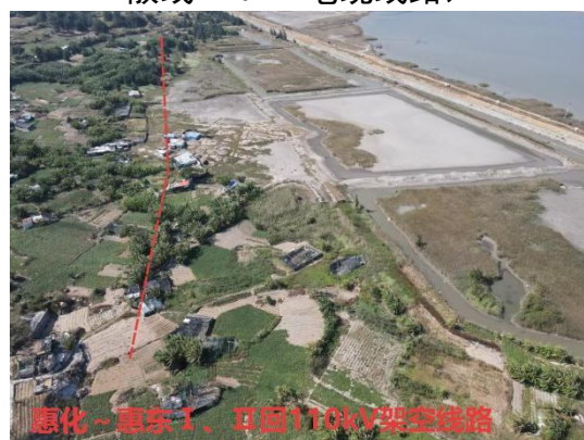
拟建架空线路周边现状（110kV 双回架空段）
