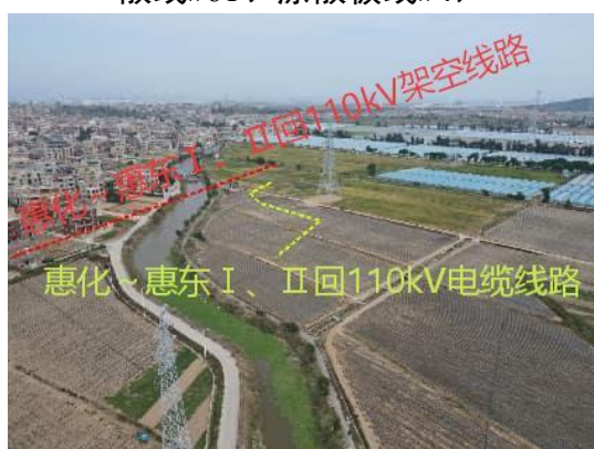
拟建电缆线路周边现状（沿农田走线）
