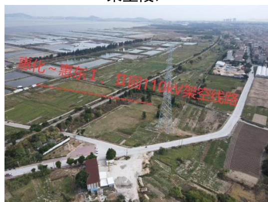
本工程拟建 110kV 线路沿线环境（跨越湄洲湾南岸铁路支线）
