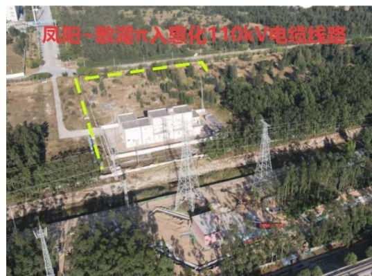
拟建电缆线路周边现状（本期开断凤散线 110kV 电缆线路）
