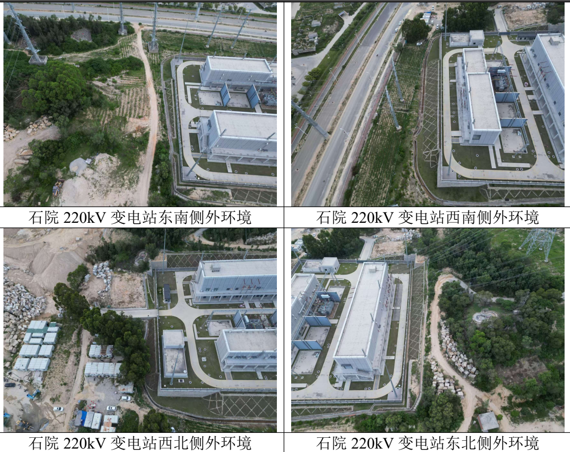
图 3-1 本项目石院 220kV 变电站周边环境照片
