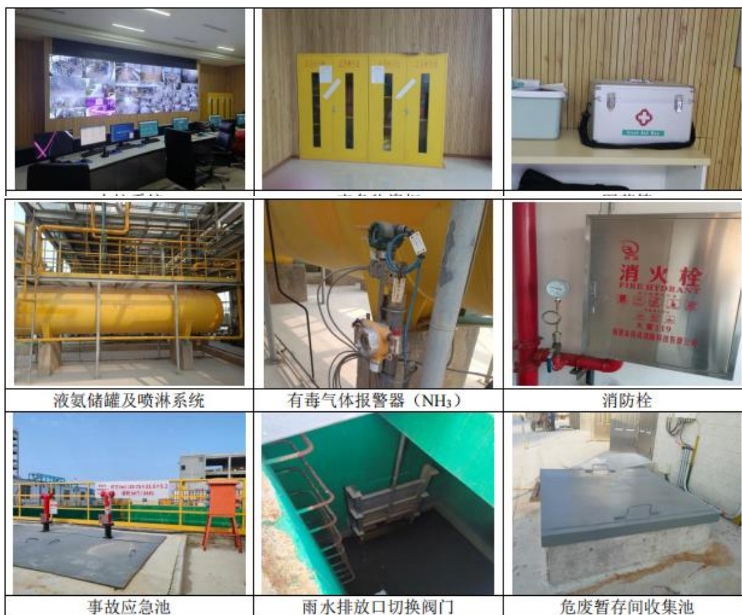
图 7.10-1 应急设施和应急物资现场调查情况图
