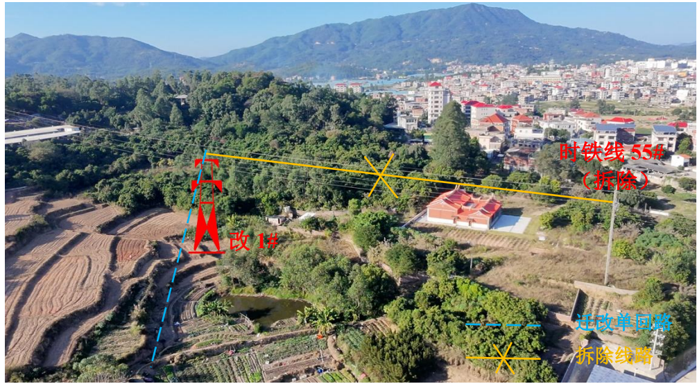
迁改架空线路路径植被现状
