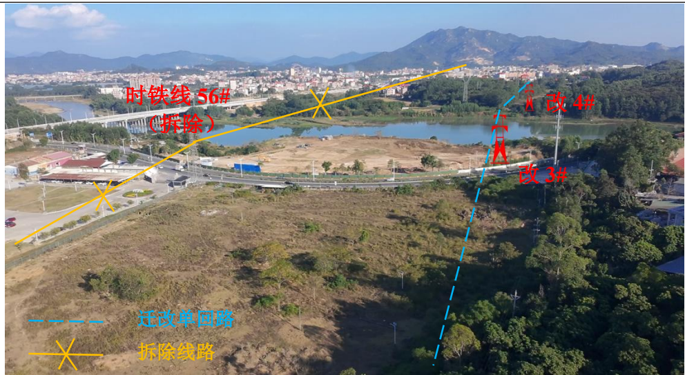
迁改架空线路路径现状（跨东溪河流）
