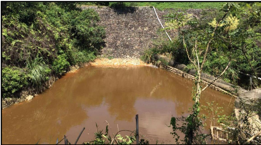
垃圾填埋场渗滤液调节池
