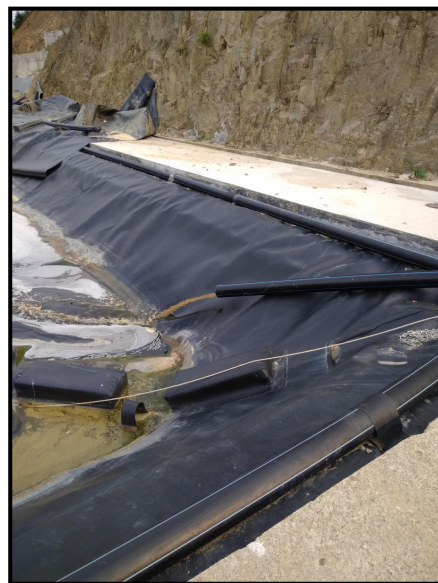
火烧寮垃圾填埋场引至高内坑填埋场渗滤液管网
