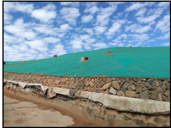
垃圾填埋场封场覆盖
