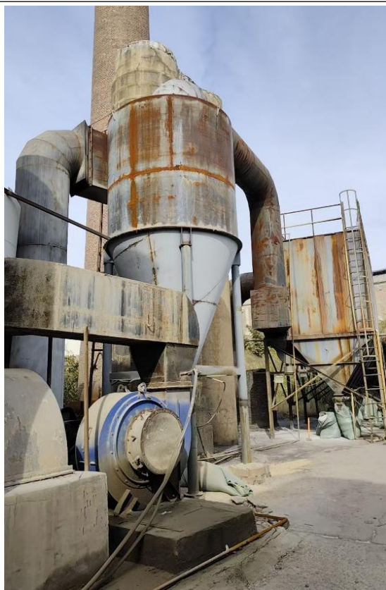
旋风布袋除尘和脱硫塔
