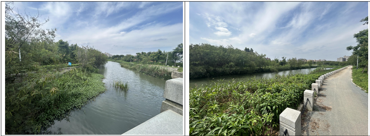
图 2-1 项目所涉河段梧桐溪现状照片
