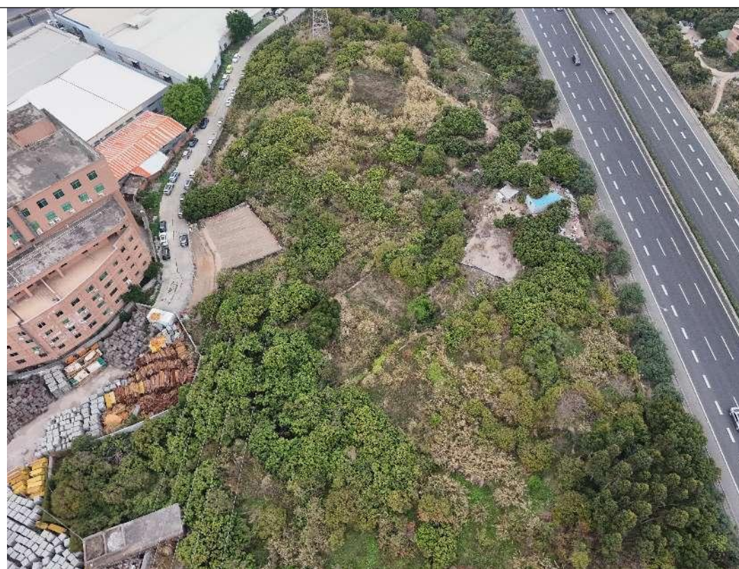
站址现状以及线路沿线现状
