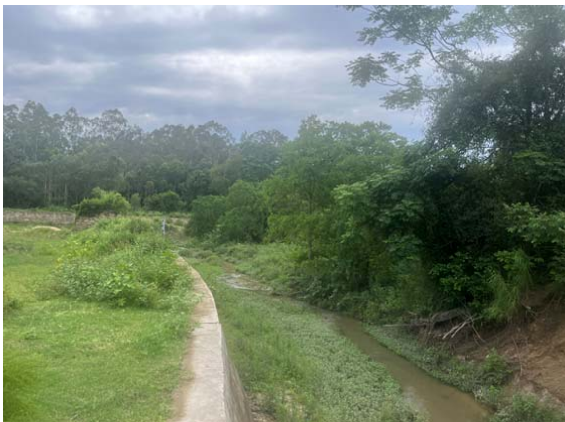
图 4-4 院仔溪现场照片
