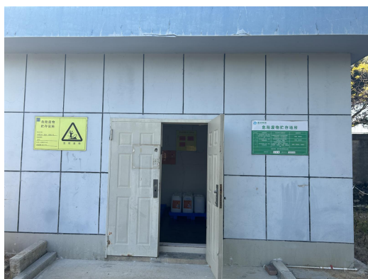
危险废物暂存间（外部）
