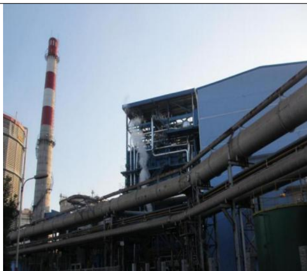
DA001 30MW发电出口
