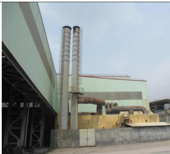
DA036 高速棒材生产线热处理炉出口
