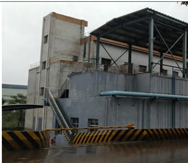
厂区废水处理站
