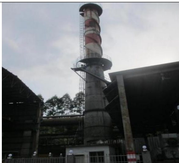
DA002 38MW 发电出口
