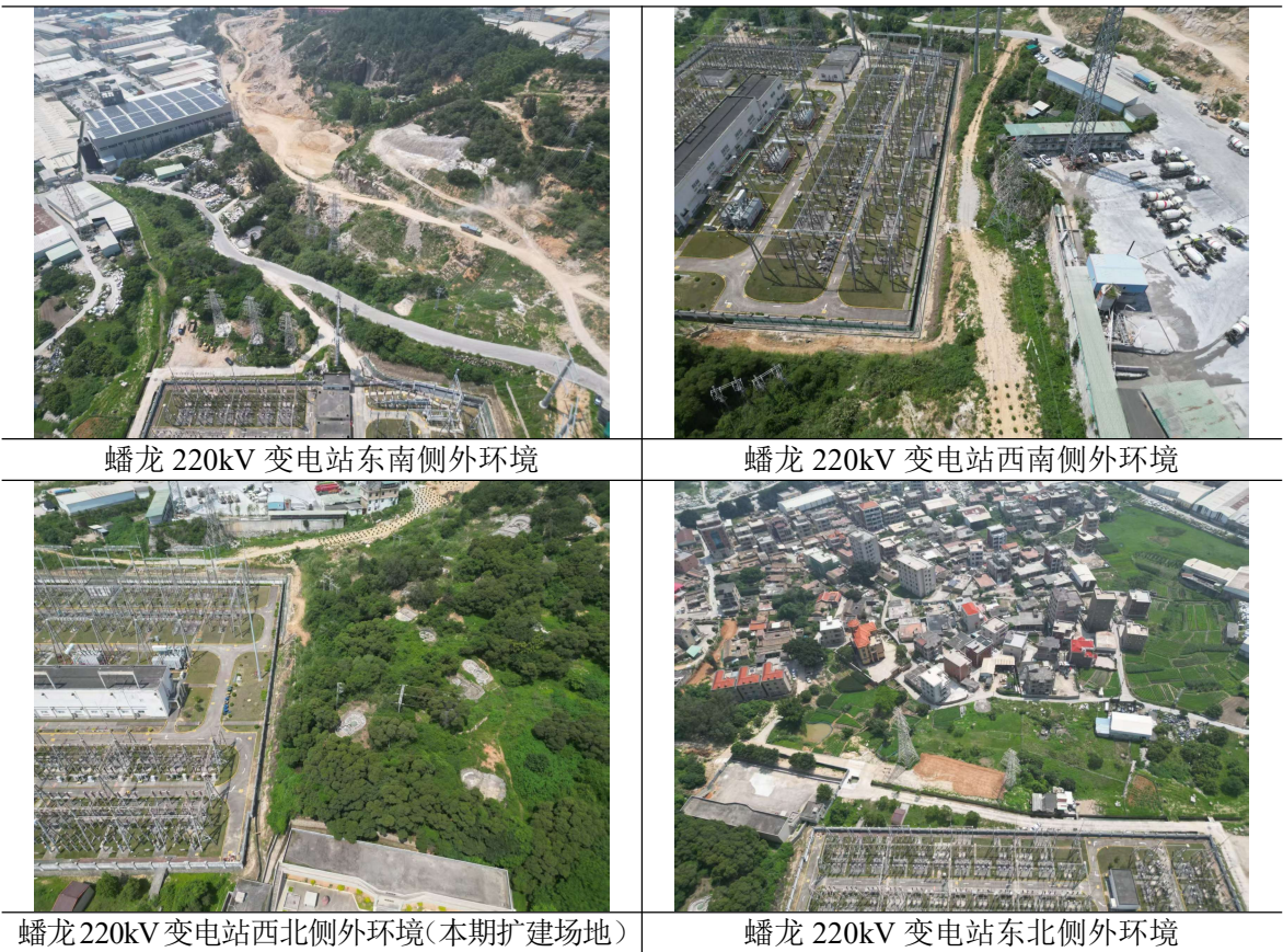
图 3-1 本项目蟠龙 220kV 变电站周边环境照片
