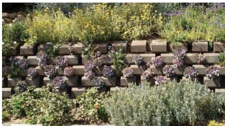
图 2.5-6 新型砌块挡墙结构示意图
