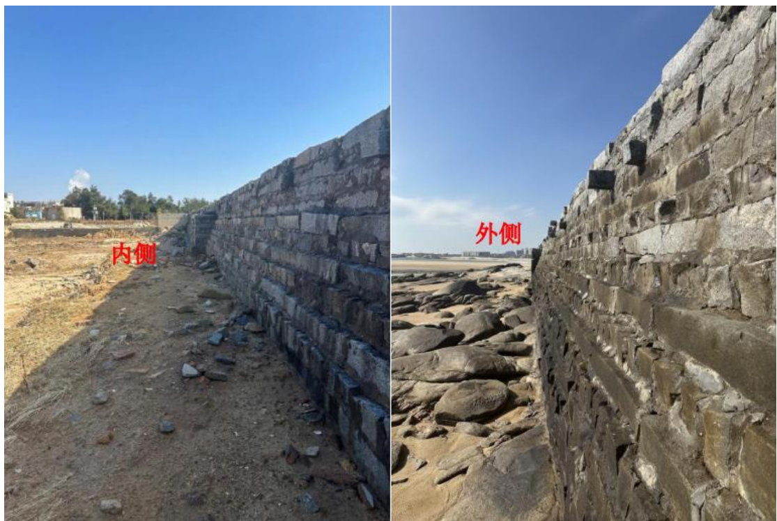
图 3.2-15 拟拆除的西围海区外侧海堤现状
