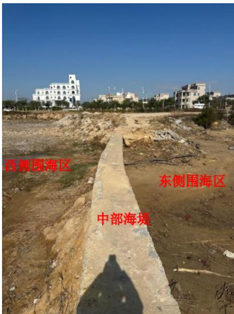
图 3.2-17 拟拆除的中部海堤现状
