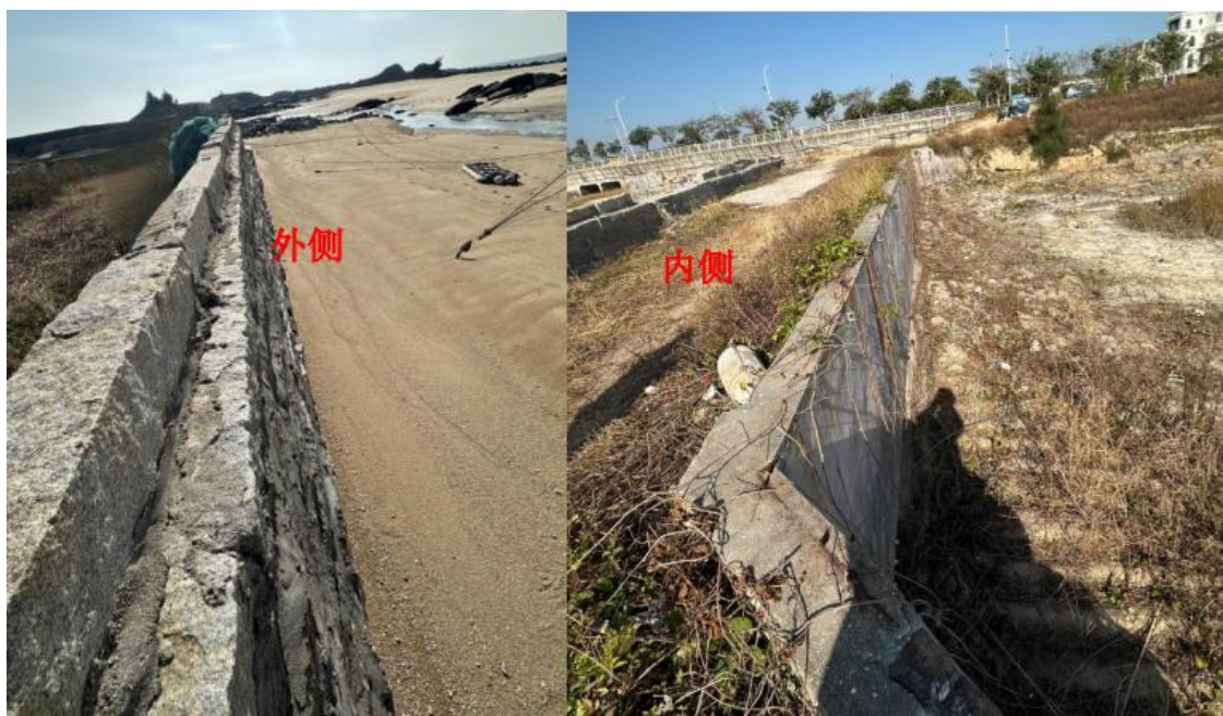
图 3.2-14 拟拆除的西侧海堤现状
