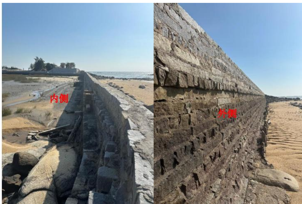
图 3.2-16 拟拆除的东围海区外侧海堤现状
