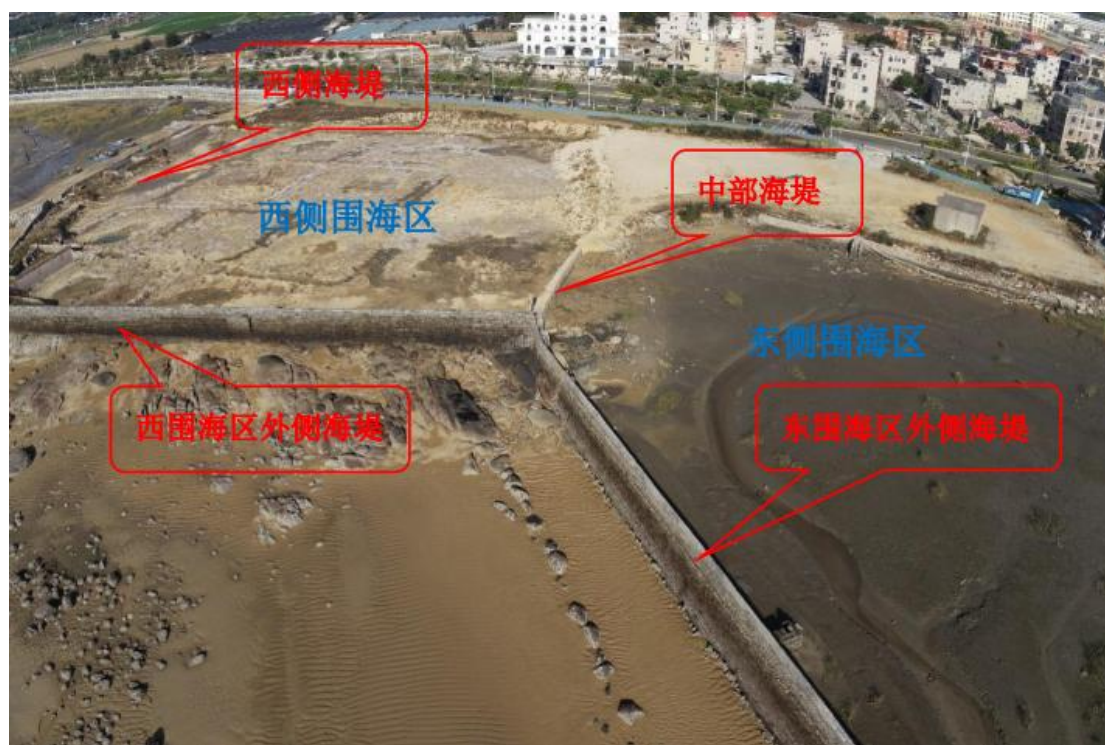
图 3.2-13 修复区现状航拍图
