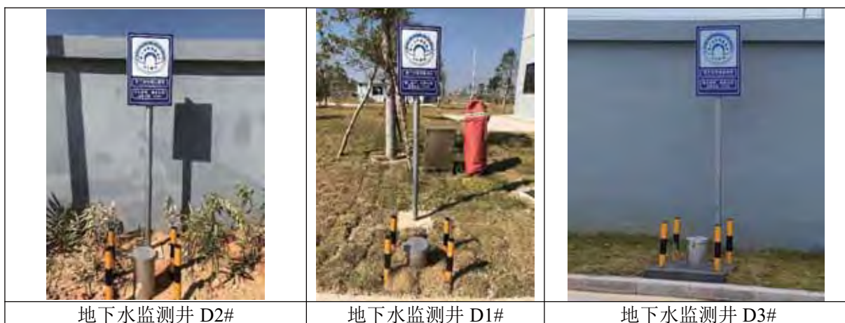
图 6.2-9 厂区已建地下水监测井
