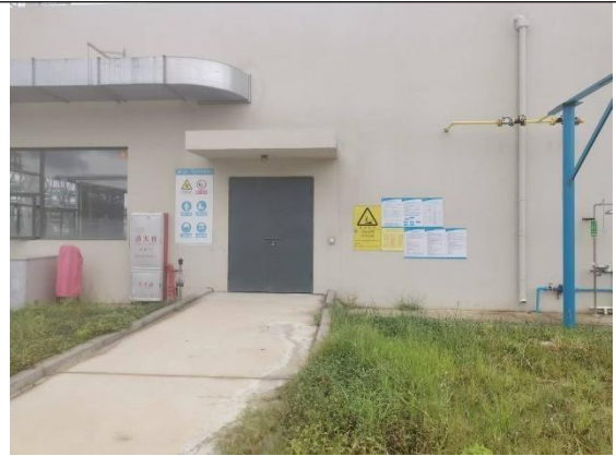
危险废物暂存间
