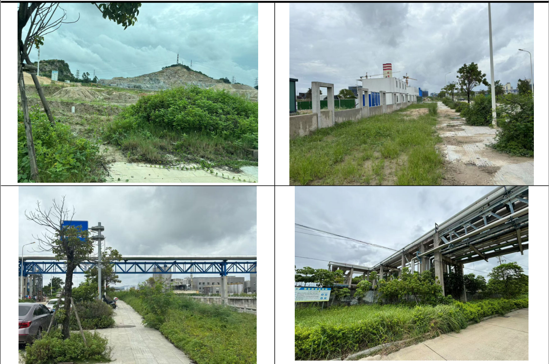
图 3.1.1 项目周围地形地貌现状照片
