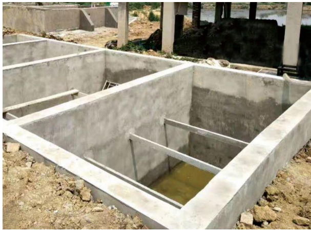
污水处理站设备拆除、池体清空
