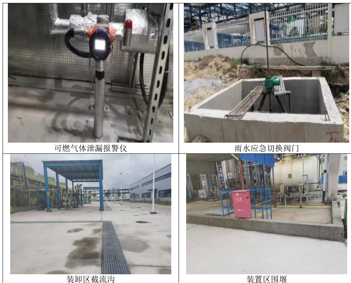
图 3.11-2 现场防范措施照片
