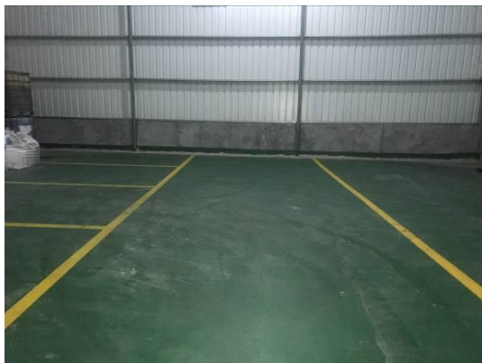
危废暂存间环氧树脂涂层（依托聚纤公司）
