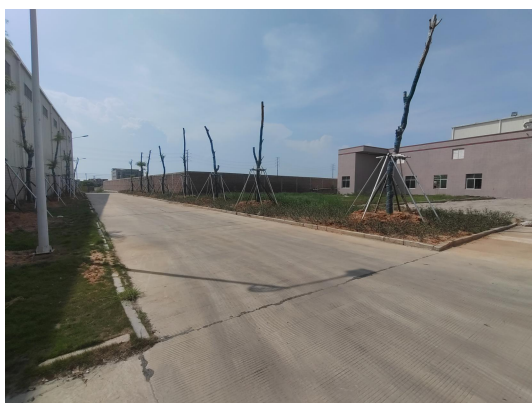
原有 E 区事故废水池恢复为绿地
