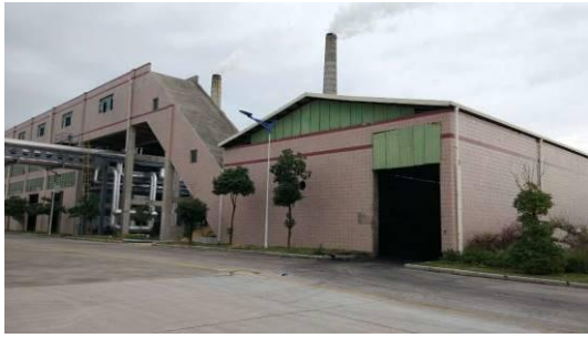
封闭煤仓及封闭输煤廊道
