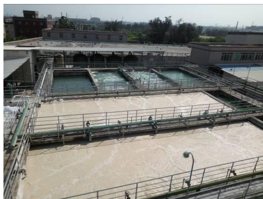
百宏聚纤公司污水处理站（依托设施）
