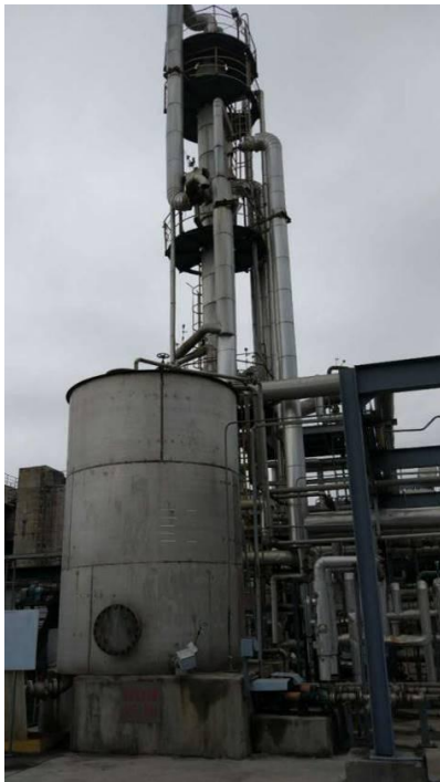
2#热媒站废水汽提塔
