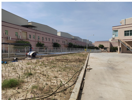
百宏集团 E、F、G 区事故废水提升泵站
