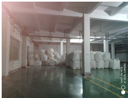
一般固废仓库防渗环氧树脂涂层
