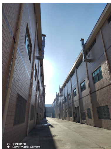
项目拉膜车间废气排气筒
