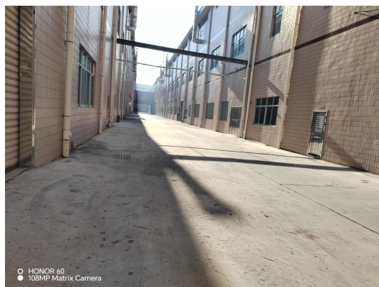
项目厂区拉膜车间
