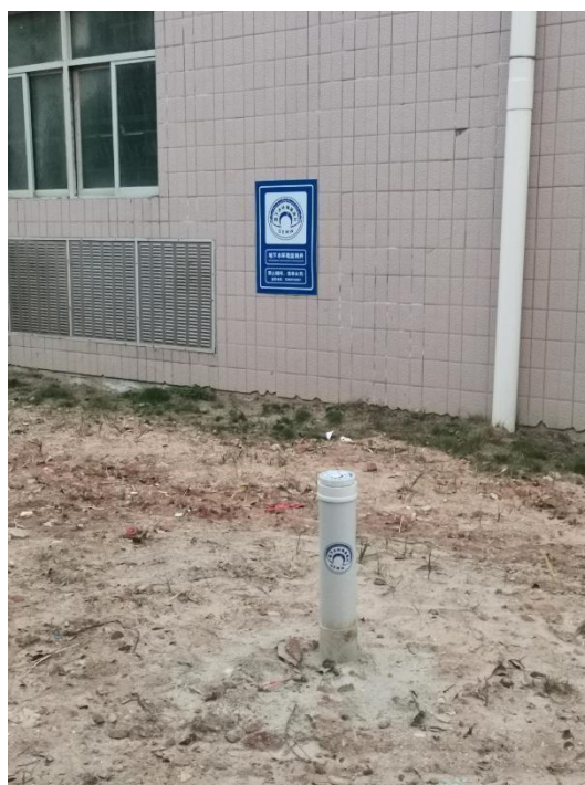
地下水监控井
