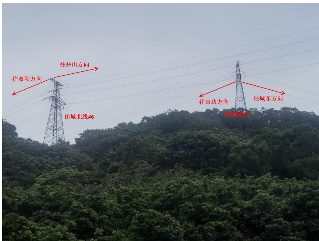
田城北线#6、田城线#23 线路塔基现状
